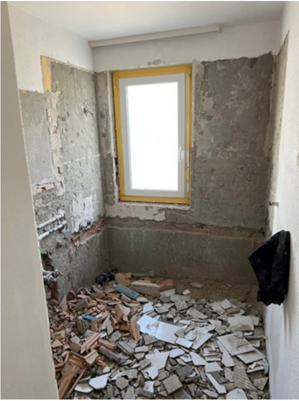
Blick in das alte Badezimmer.
