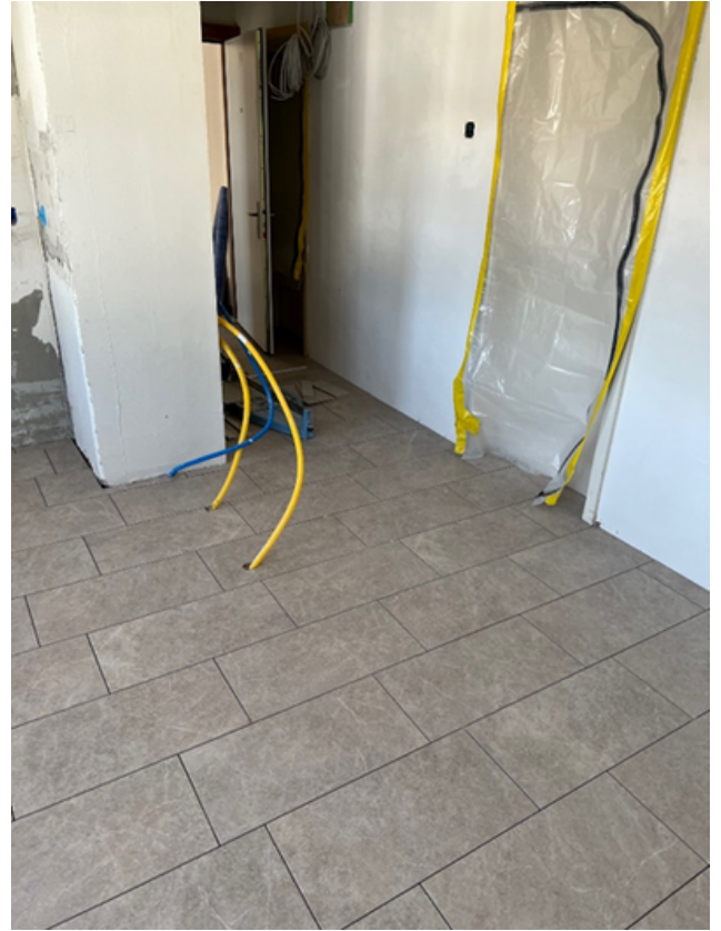
Bereits ist der Boden in der Küche aufgefüllt und der Boden mit Platten belegt.
